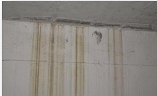
Infiltrazioni d'acqua nel raccordo muro/solaio
