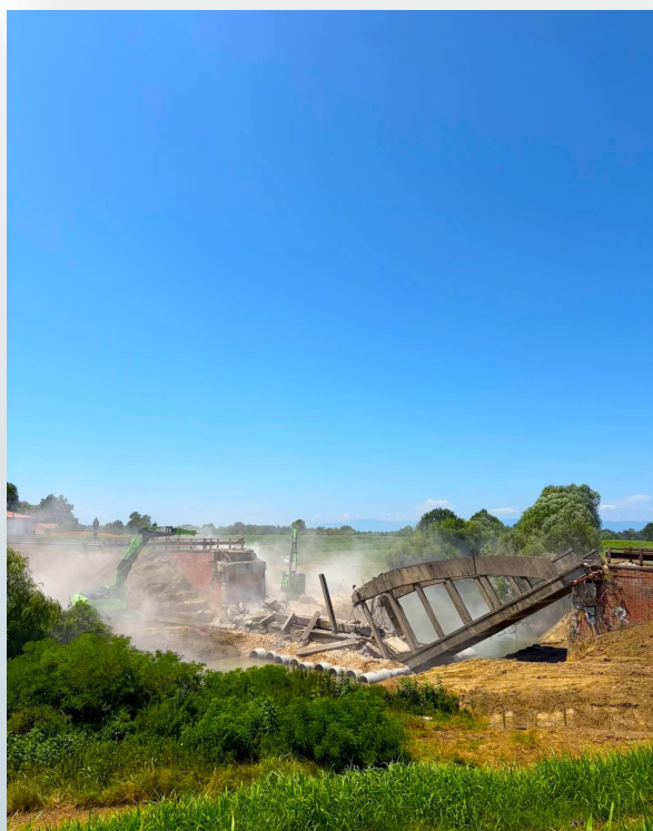
La demolizione del "ponte"
